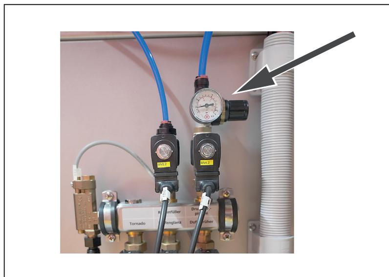
Abb. 4 - 6 Druckregler und Manometer für Betriebseinstellung Cockpit-Druckluftpistole
